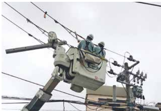
機器交換工事の様子
