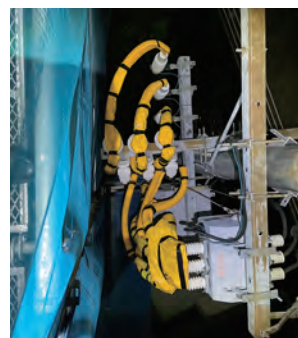
高圧絶縁用防護カバー取り付け
