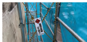
立入禁止の応急措置
