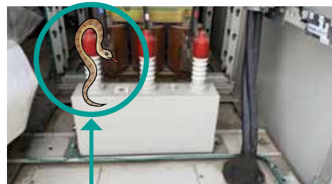
高圧コンデンサに接触したヘビ
