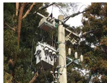
伐採後の引込柱周辺
