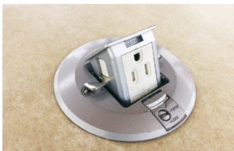
漏電していたコンセント
