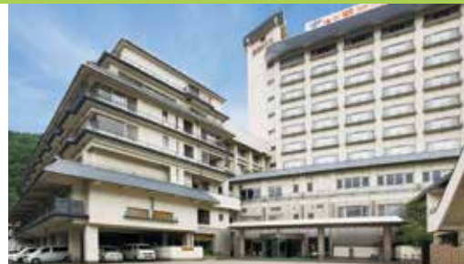
源蔵の湯 鳴子観光ホテル外観
