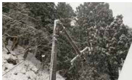
電柱が折れている
