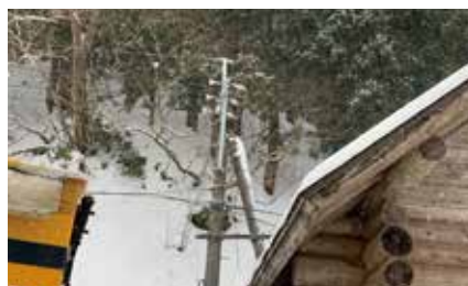
アームを取り付け仮復旧
