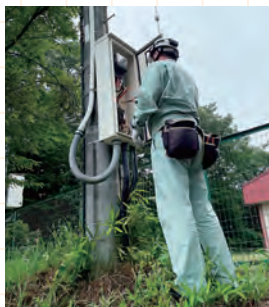
電力量計周辺の点検
