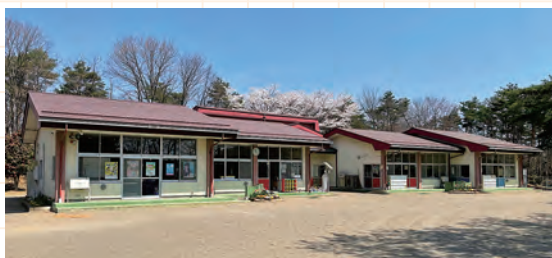
点検を実施させていただいた幼稚園
