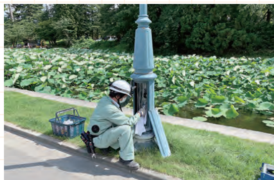
約40基の外灯目視点検を実施しました
