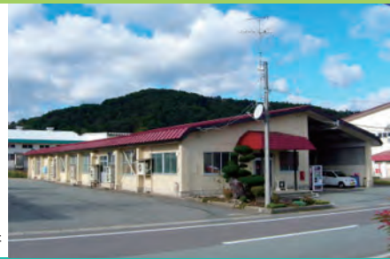
村山市の工業団地に立地する株式会社ツープラ技研
