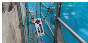
立入禁止の応急措置
