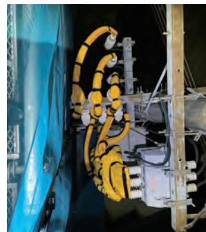
高圧絶縁用防護カバー取り付け
