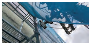
工事用足場が近接
