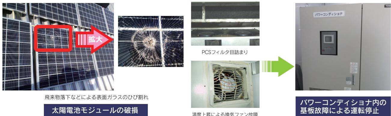
飛来物落下などによる表面ガラスのひび割れ
